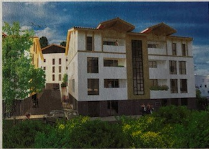
A Anglet, le Clos d'Ainara est un chantier pilote en déconstruction sélective, agence d'architecture AADI.
